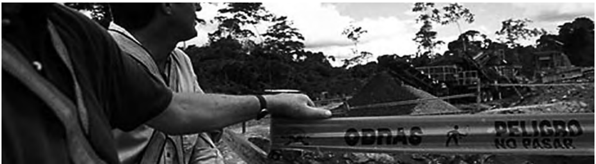
Foto der Baustelle des Camisea-Projektes
